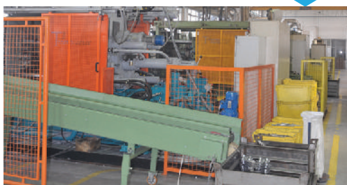
Livnica Foundry Литейный цех
